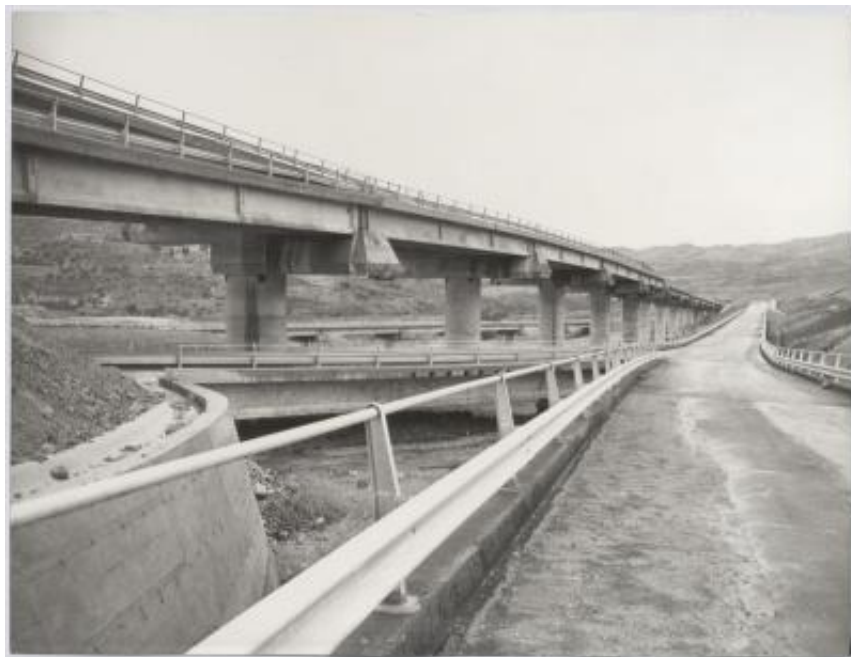
Impalcati prefabbricati utilizzati nella realizzazione dell'autostrada Catania-Messina
