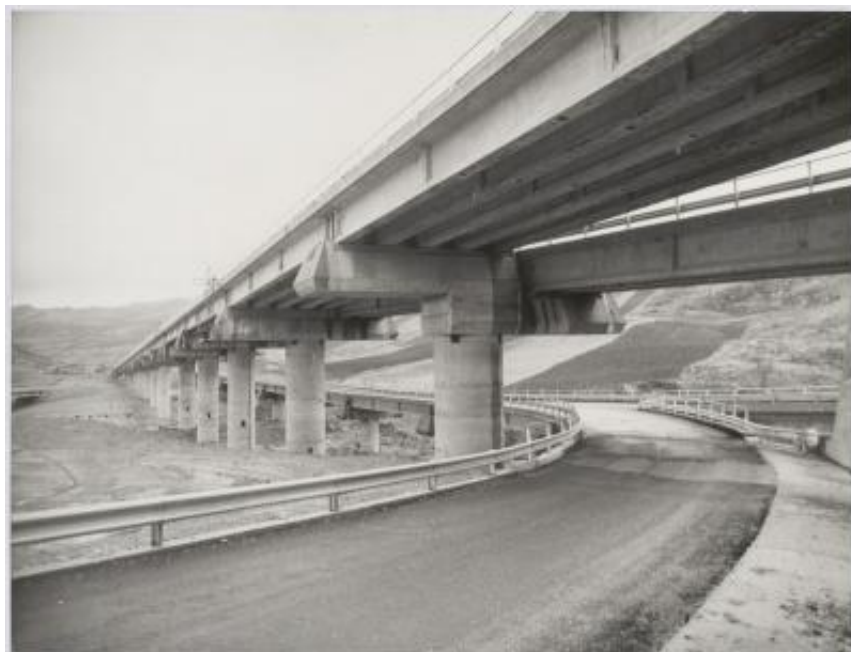
Impalcati prefabbricati utilizzati nella realizzazione dell'autostrada Catania-Messina
