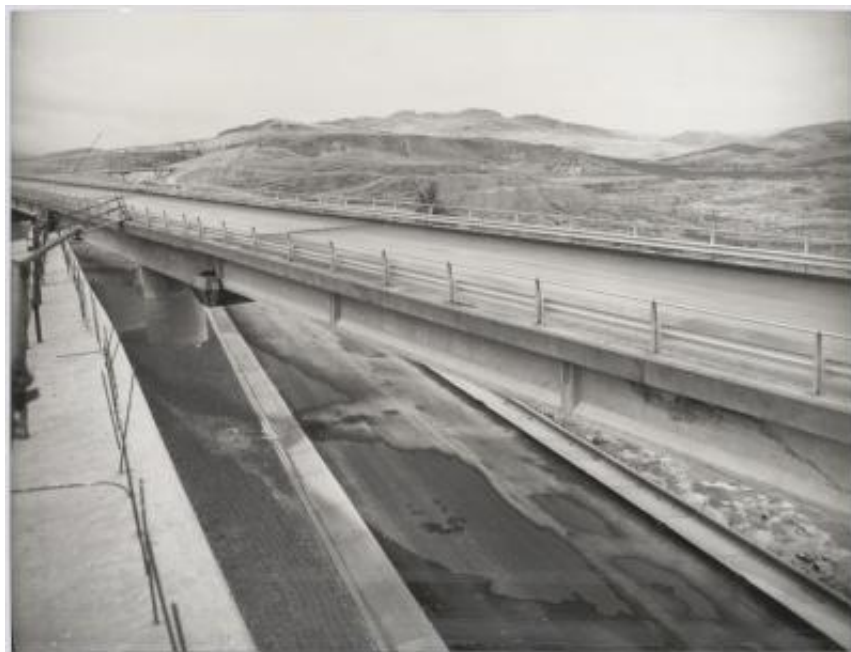
Impalcati prefabbricati utilizzati nella realizzazione dell'autostrada Catania-Messina
