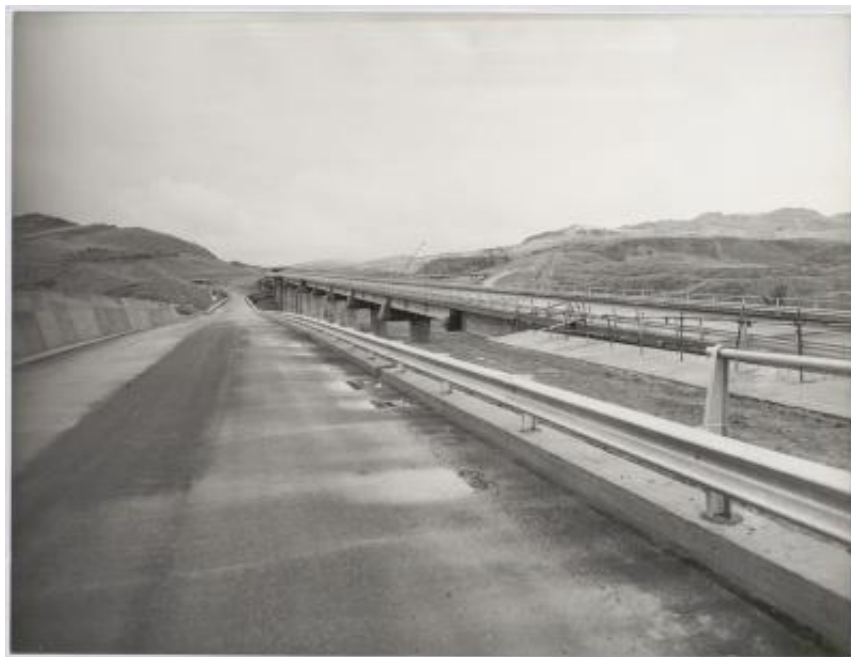
Impalcati prefabbricati utilizzati nella realizzazione dell'autostrada Catania-Messina
