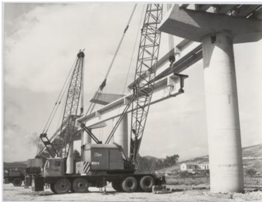
Impalcati prefabbricati utilizzati nella realizzazione dell'autostrada Catania-Messina
