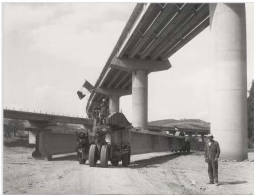
Impalcati prefabbricati utilizzati nella realizzazione dell'autostrada Catania-Messina
