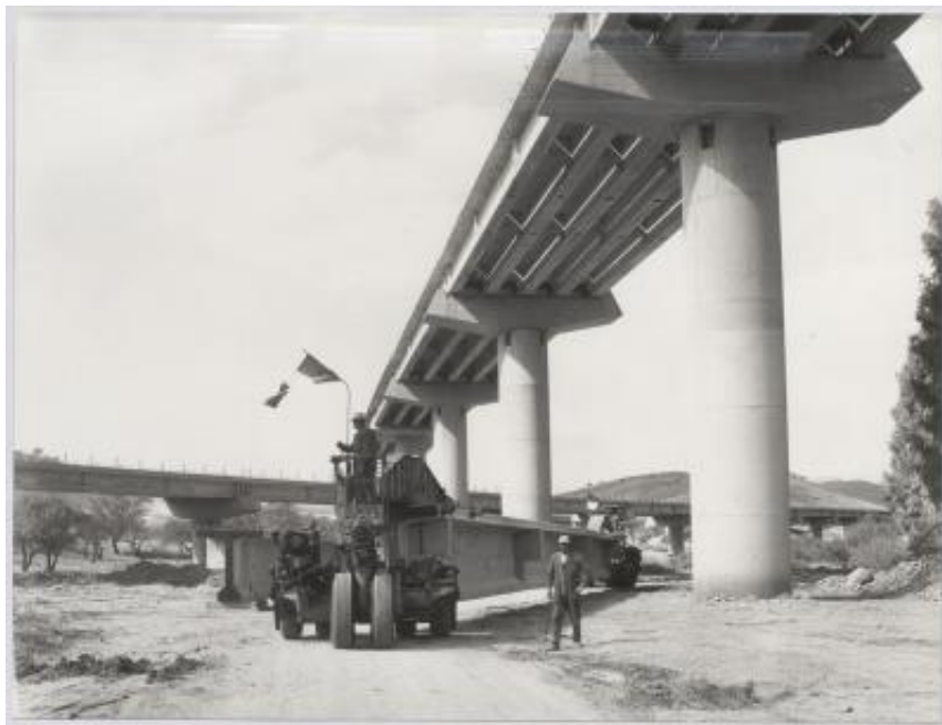
Impalcati prefabbricati utilizzati nella realizzazione dell'autostrada Catania-Messina
