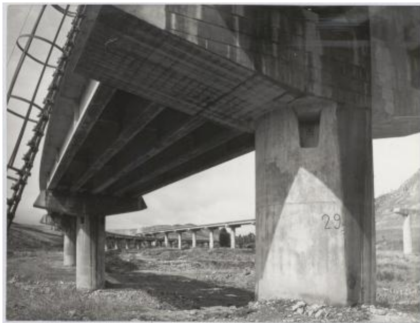
Impalcati prefabbricati utilizzati nella realizzazione dell'autostrada Catania-Messina
