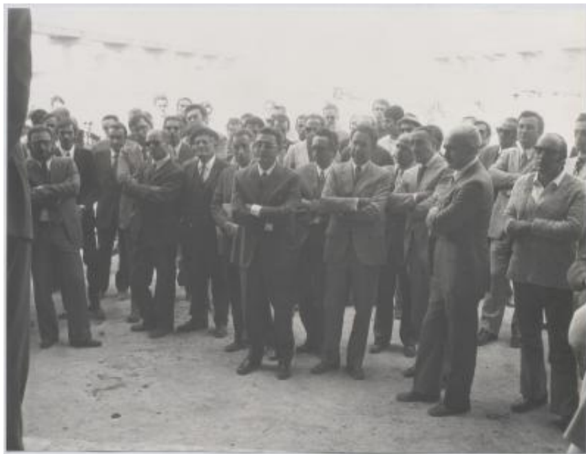
Pubblico in ascolto del discorso di Silvano Zorzi tenuto presso il cantiere dell'autostrada Catania-Messina
