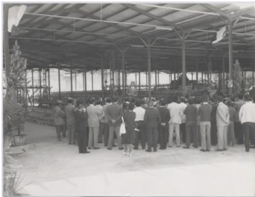
Intervento di Silvano Zorzi presso il cantiere dell'autostrada Catania-Messina
