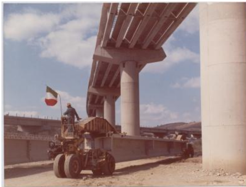
Impalcati prefabbricati utilizzati nella realizzazione dell'autostrada Catania-Messina
