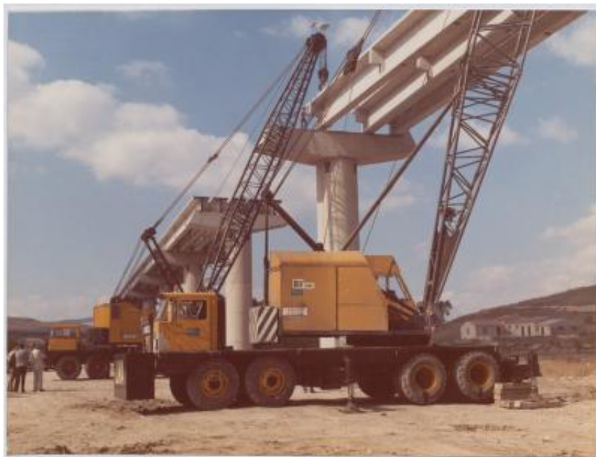
Impalcati prefabbricati utilizzati nella realizzazione dell'autostrada Catania-Messina
