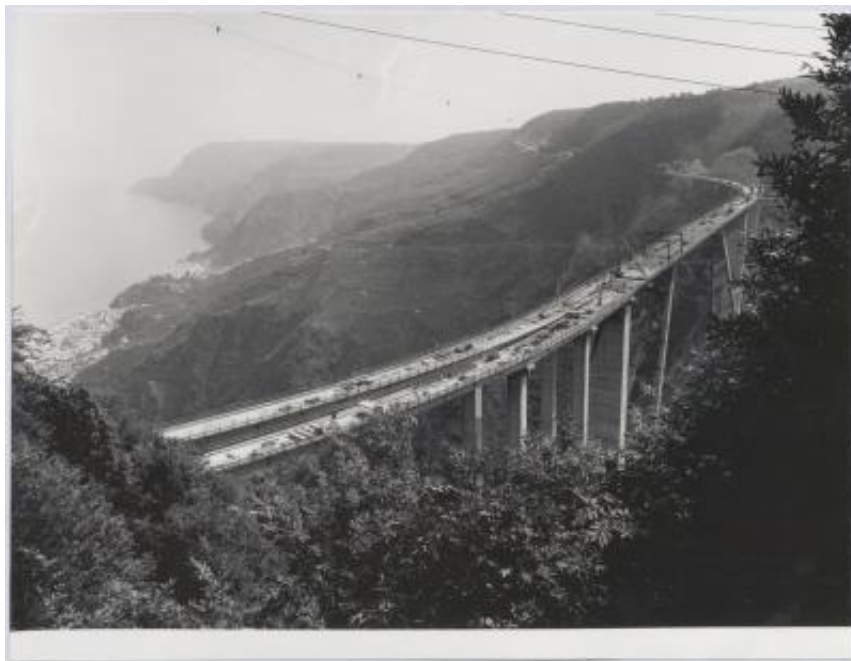
Viadotto sul torrente Sfalassà per l'autostrada Salerno-Reggio Calabria
