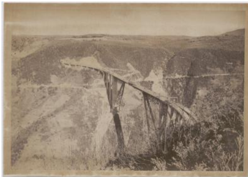
Viadotto sul torrente Sfalassà per l'autostrada Salerno-Reggio Calabria
