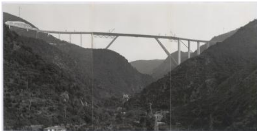
Viadotto sul torrente Sfalassà per l'autostrada Salerno-Reggio Calabria
