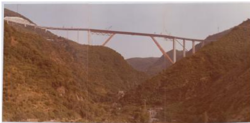
Viadotto sul torrente Sfalassà per l'autostrada Salerno-Reggio Calabria
