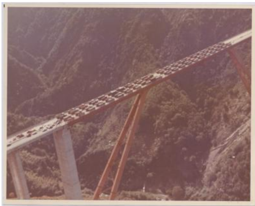
Viadotto sul torrente Sfalassà per l'autostrada Salerno-Reggio Calabria
