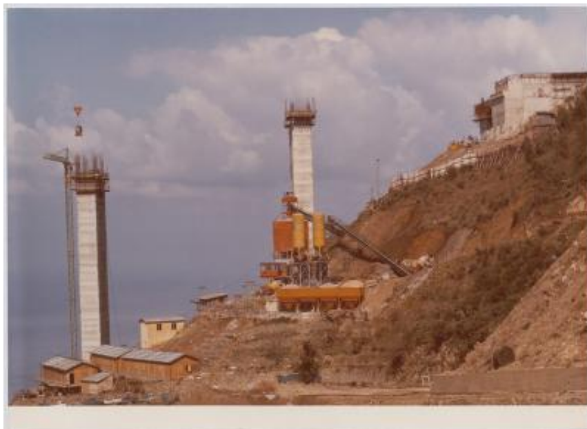
Viadotto sul torrente Sfalassà per l'autostrada Salerno-Reggio Calabria
