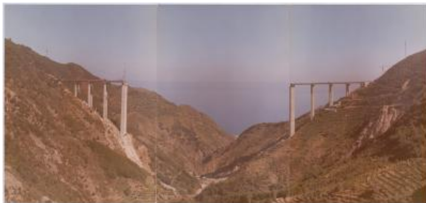
Viadotto sul torrente Sfalassà per l'autostrada Salerno-Reggio Calabria
