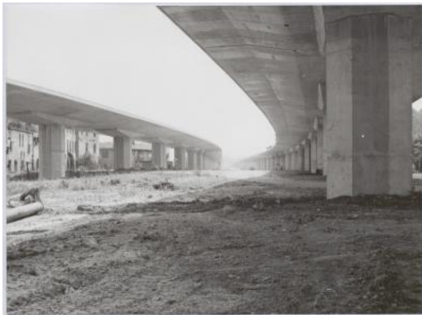
Viadotto dei Parchi per l'autostrada tangenziale est alla città di Milano
