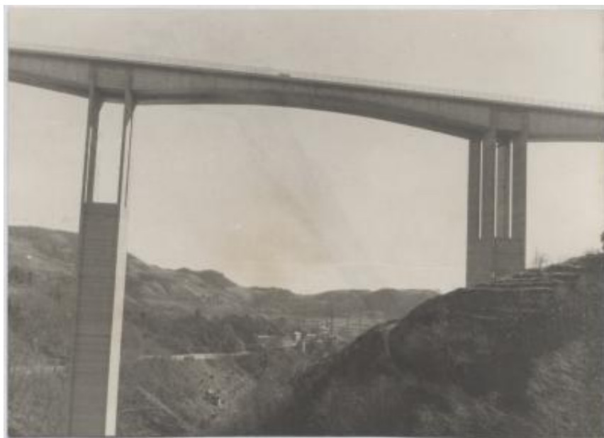
Viadotto sul torrente Gorsexio per l'Autostrada dei Trafori
