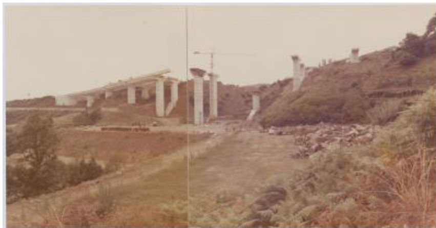
Viadotto sul torrente Gorsexio per l'Autostrada dei Trafori
