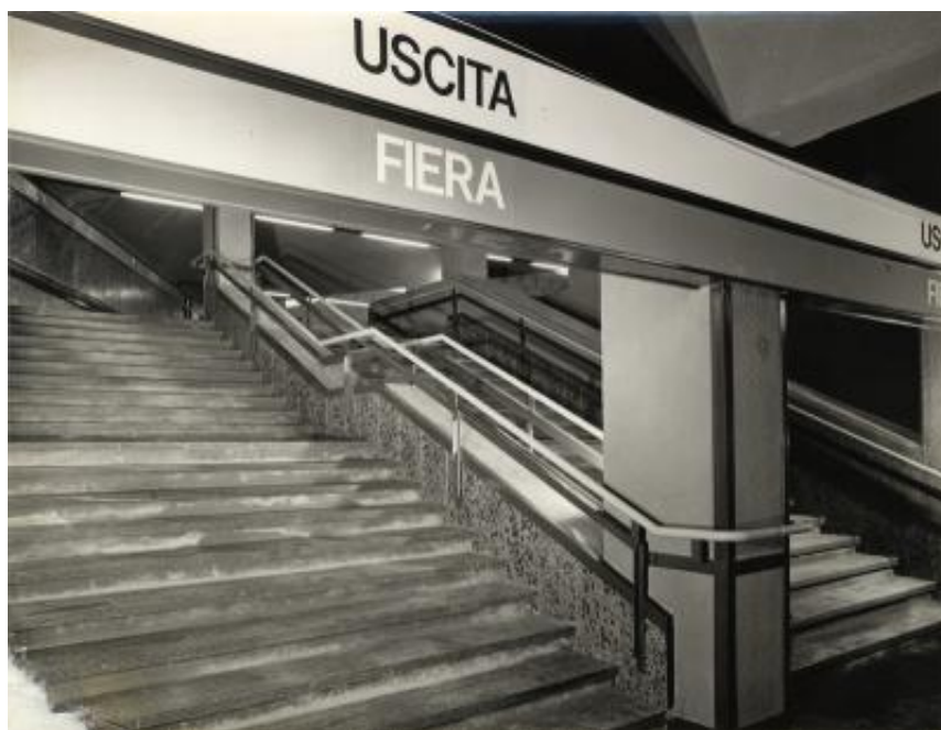
Scalinata interna della stazione metropolitana Amendola Fiera a Milano
