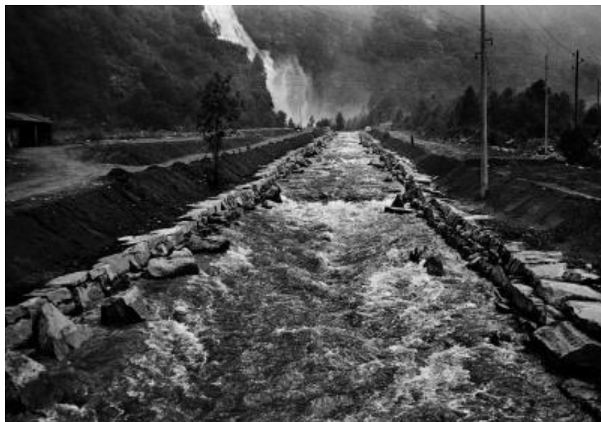
Giornico, Torrente Cramosina. Situazione 21 giugno 1961, ore 18.35-18.45, portata del Cramosina veduta dal nuovo ponte verso monte
