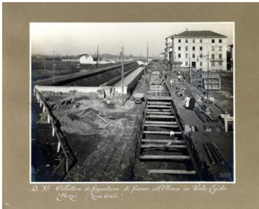
A. X° Collettore di fognatura di fianco all'Olona in Viale Egisto Bezzi (Zona Ovest.)
