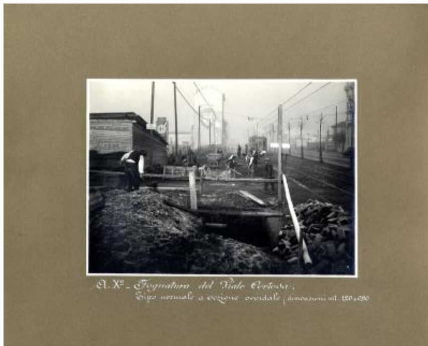
A. X° Fognatura del Viale Certosa. Tipo normale a sezione ovoidale (dimensioni mt. 1.20x0.80).
