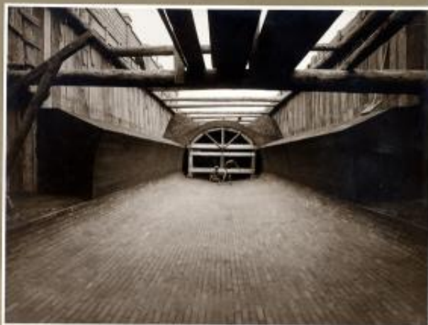
A. X° Collettore fognatura Zona Est fra le Vie Lombroso e Piranesi nei diversi stadi di lavoro.
