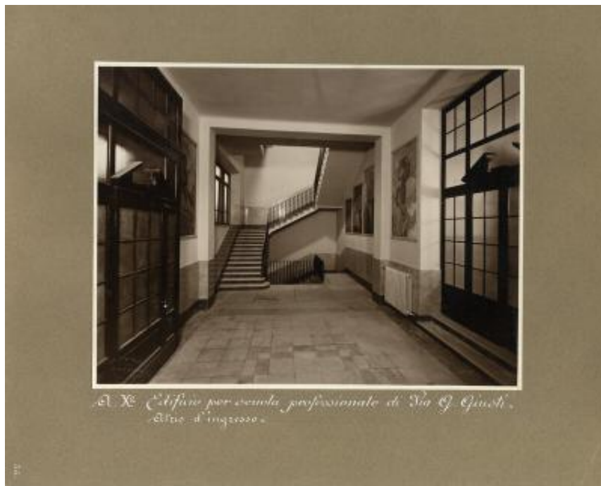
A. X° Edificio per scuole professionali di Via G. Giusti. Atrio d'ingresso.
