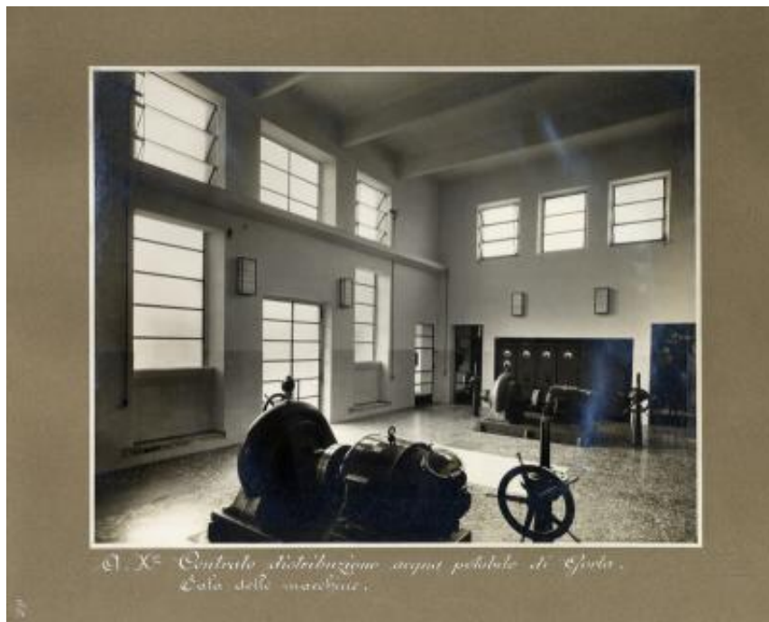
A. X° Centrale di distribuzione acqua potabile di Gorla. Sala delle macchine.
