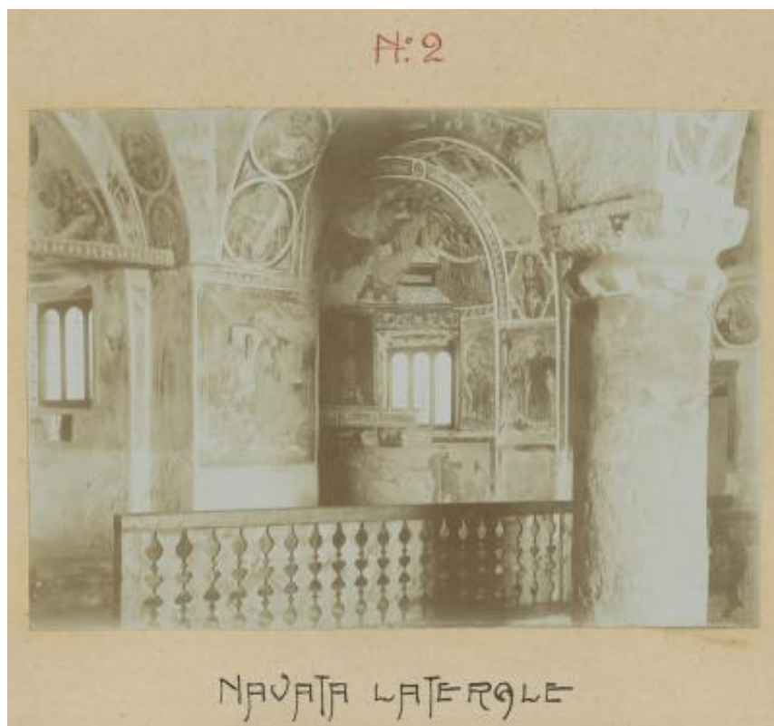
Veduta della navata laterale della chiesa di San Carlo Borromeo ad Acquarossa
