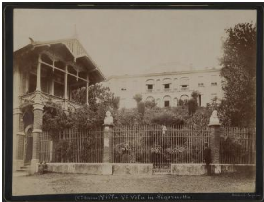
Veduta della portineria di Villa Vela
