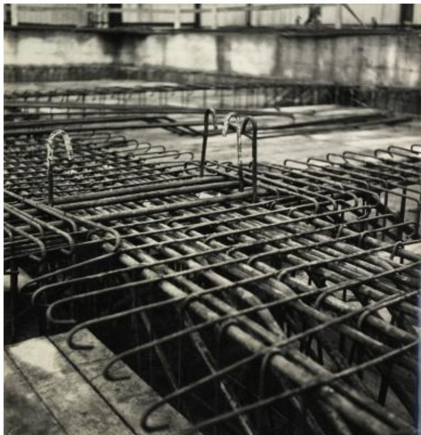
Particolare dell'armatura metallica della soletta a copertura della stazione Cadorna
