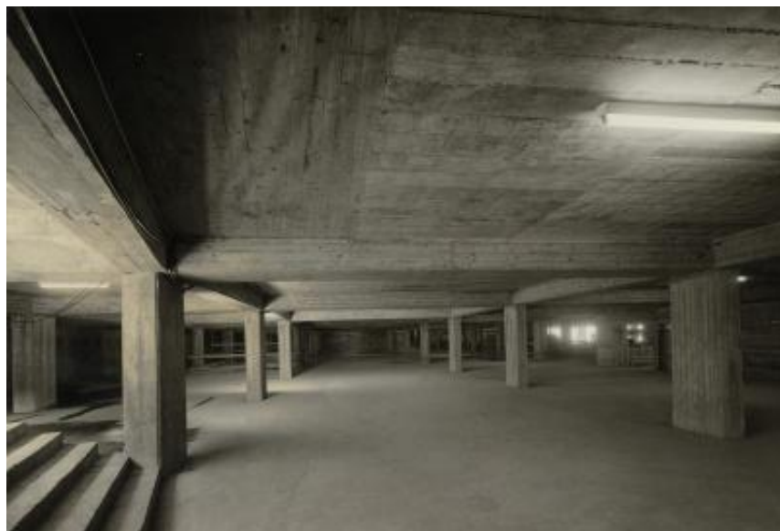
Mezzanino della stazione Cadorna
