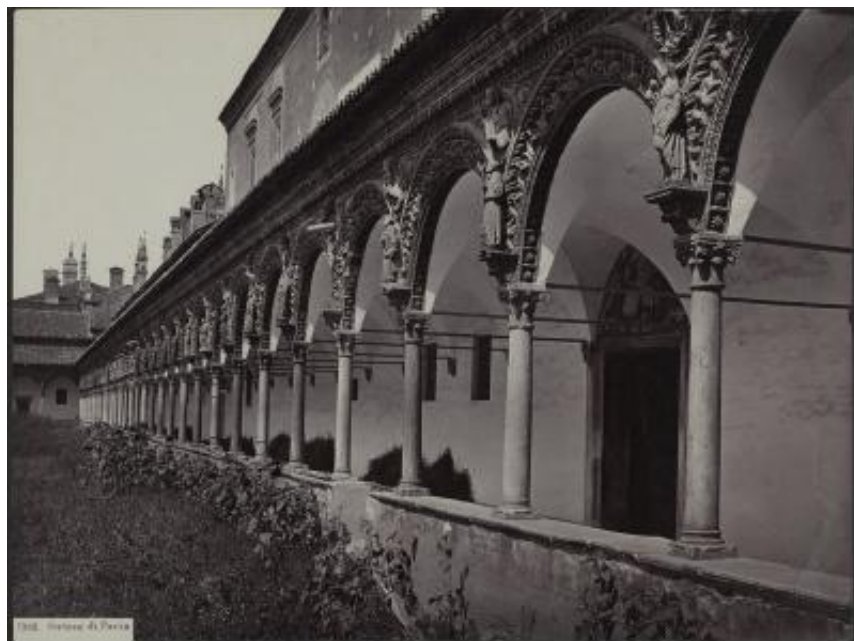
Loggiato del Chiostro piccolo del monastero della Certosa di Pavia
