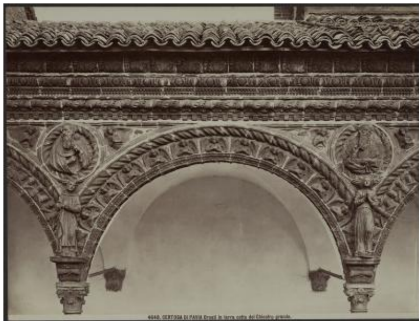
Ornati in terra cotta del loggiato del Chiostro grande della Certosa di Pavia
