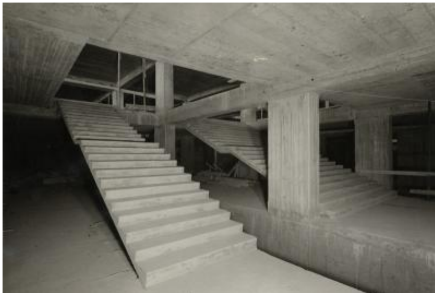
Particolare delle scale della stazione Cadorna a Milano
