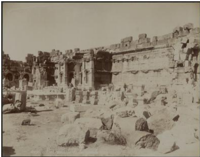
Veduta generale del cortile grande dell'area archeologica di Baalbek
