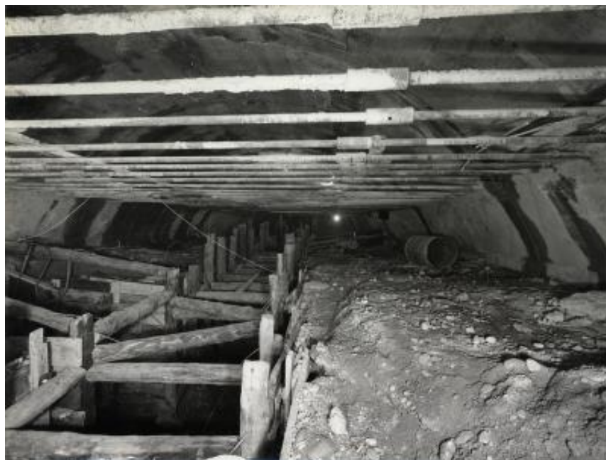
Calotta della galleria della linea 2 della metropolitana di Milano e cunicolo di avanzamento
