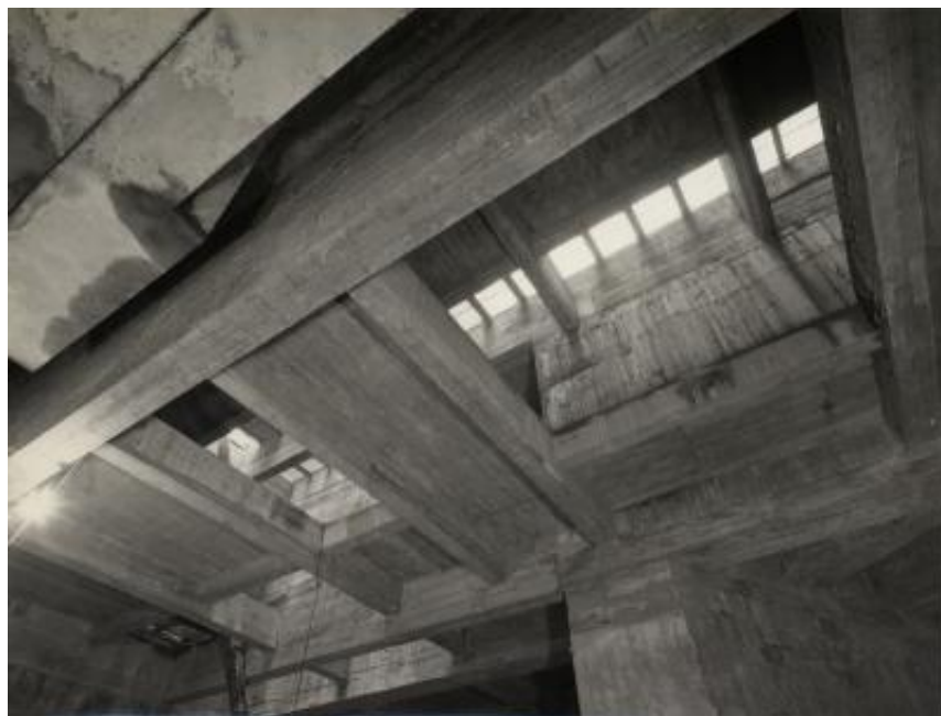
Vista della presa d'aria dall'interno della galleria del cantiere S. Spirito a Milano
