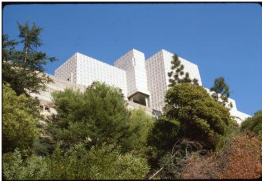
Los Feliz. Ennis House ripresa dalla base del muro di contenimento
