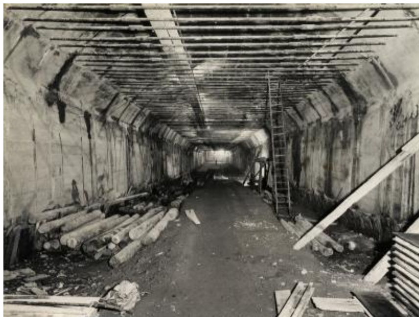
Galleria sottostante il Castello Sforzesco a Milano prima del getto dell'arco rovescio
