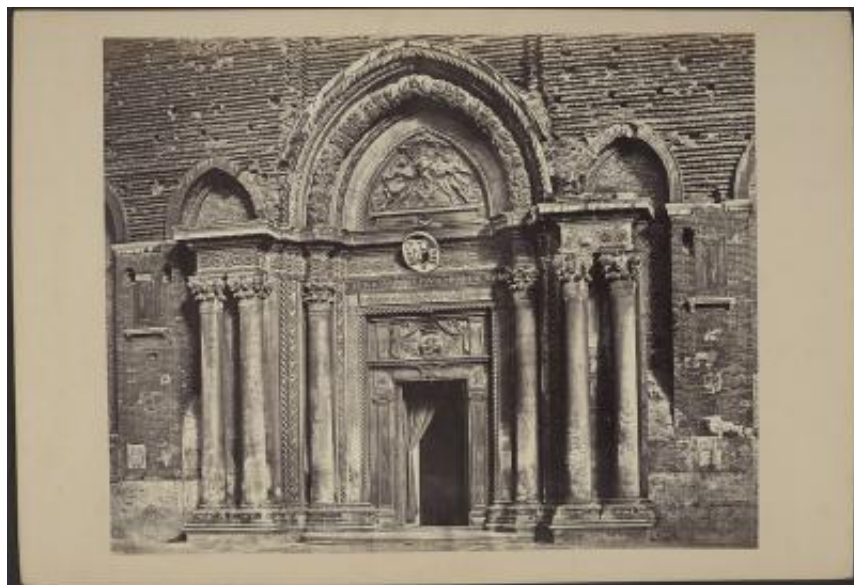
Dettaglio della facciata della Basilica dei Santi Giovanni e Paolo
