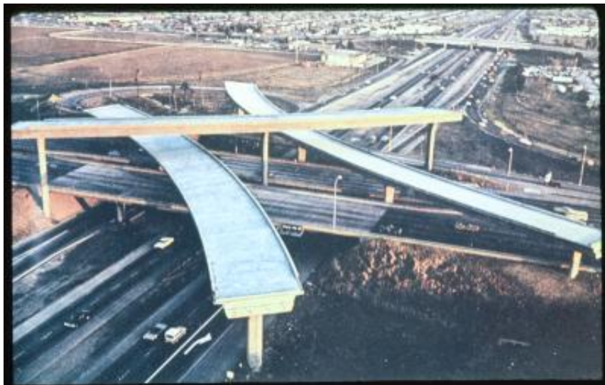
San Jose. Veduta dall'alto della strada sopraelevata in costruzione
