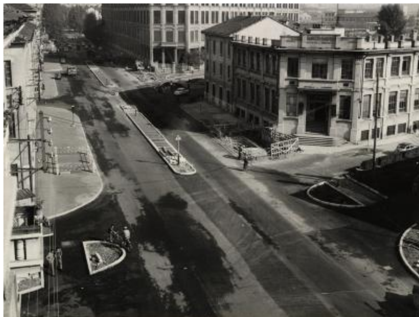
Cantiere della metropolitana presso la fermata Sesto Marelli a Sesto San Giovanni
